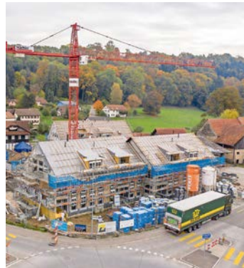
Auf der Baustelle herrscht täglich Betrieb und man kann sich sein Tageswerk vor Augen halten!
